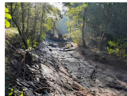
Restauration d'une annexe hydraulique sur le Bès à Morcenx-la-Nouvelle
