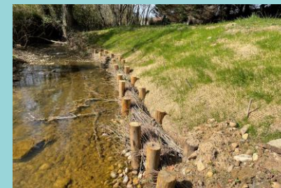
Restauration de berge en fascine et bouturage à Larrivière Saint-Savin
