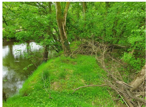
Merlon séparant la Midouze de l'annexe
