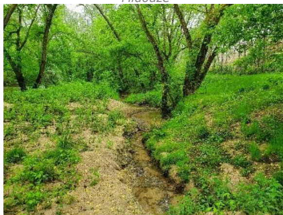
Sortie du passage busé
