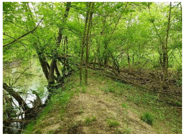
Merlon séparant la Midouze de l'annexe hydraulique
