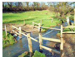
Le passage à gué doit être empierré avec un profil non horizontal dans le fond du lit et ne doit pas créer de chute dans le cours d'eau.
